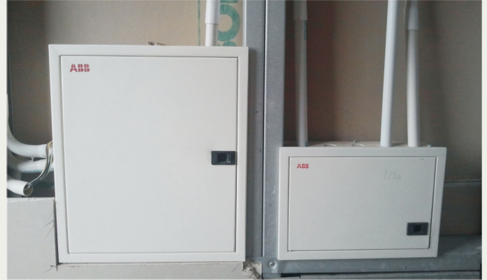
Conduit / MCB Box Fixing Arrangement
